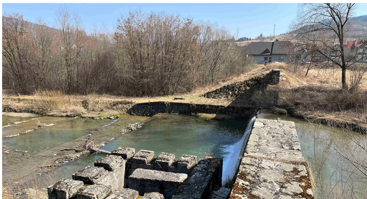
Zapora przeciwrumowiskowa z niecką wypadową, i czterema gurtami dennymi dla ograniczenia erozji koryta Lubieńki, Centrum Lubnia, około 100 m powyżej mostu (km 1+125) (fot. Paweł Mikuś, 2022-03-24)
