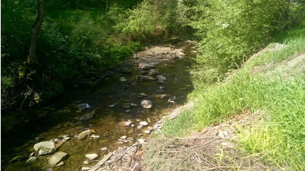
Widok z jezdni drogowej w rejonie km 2+670 w obszerne koryto Trzebuńki, do którego można wsypywać żwir bezpośrednio z samochodów samowyladowczych (fot. Józef Jeleński, 2022-05-10)
